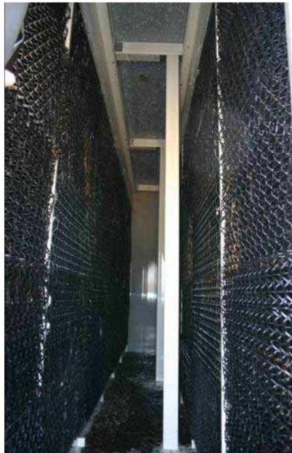
Filters met honingraatstructuur (bron: ASG 16 )
