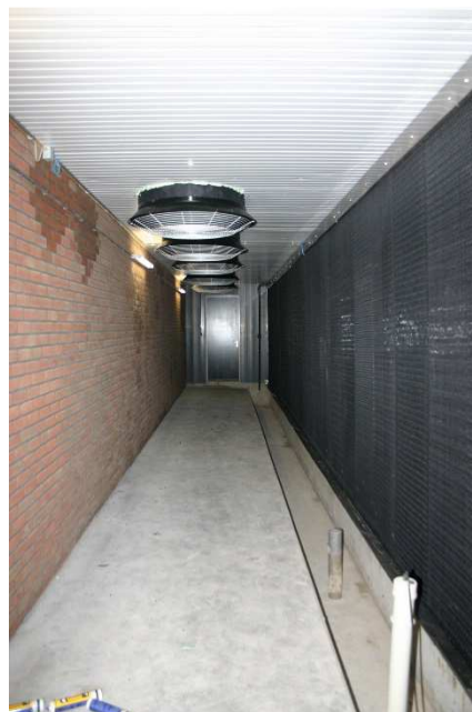
Bouwkundig luchtwassysteem (Bron: Inno+)
